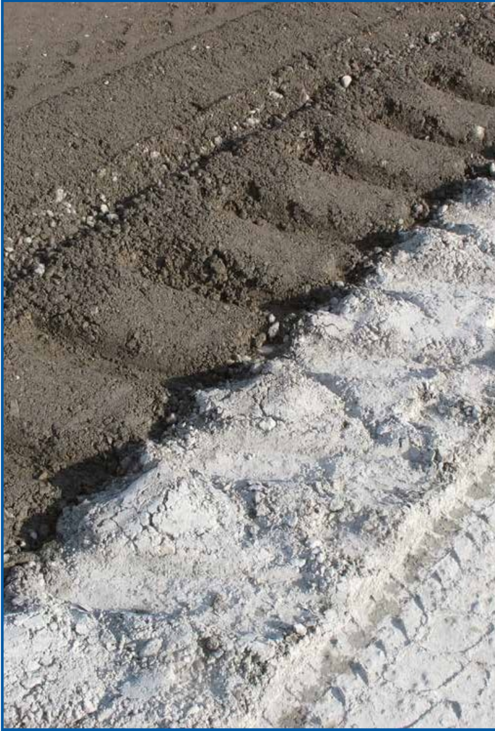
SS. E145 • Concrete stabilisation.
